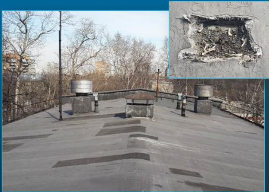
ДО КАПИТАЛЬНОГО РЕМОНТА
