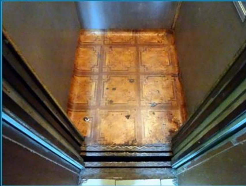
ДО КАПИТАЛЬНОГО РЕМОНТА
